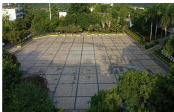
海南矿业建设矿山广场
